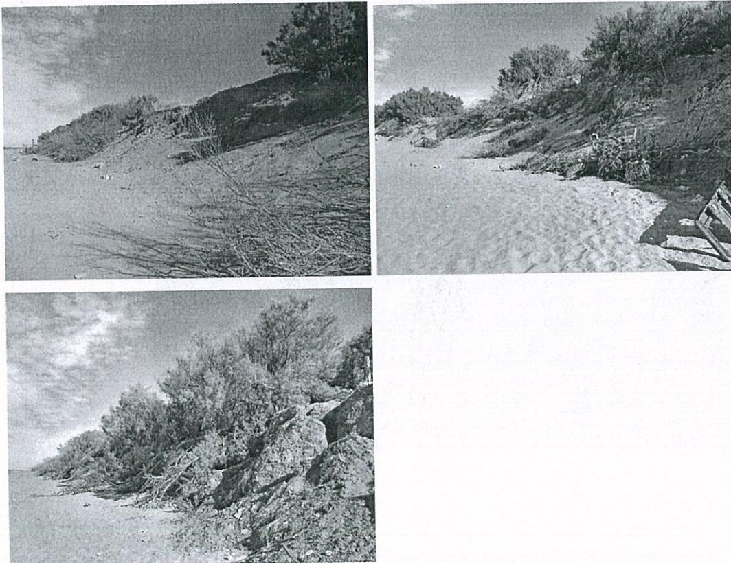
A causas de socavamiento y posterior desmoronamiento se han realizado varios intentos de fijación vegetal, como muestra la imagen, sin embargo no evita el
